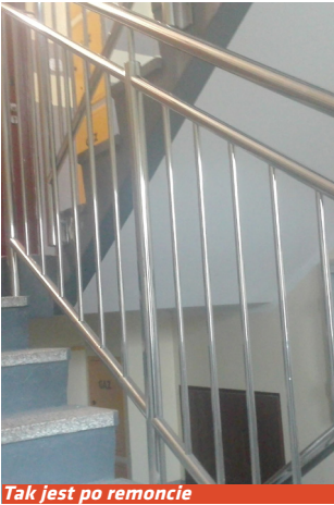
Tak jest po remoncie
